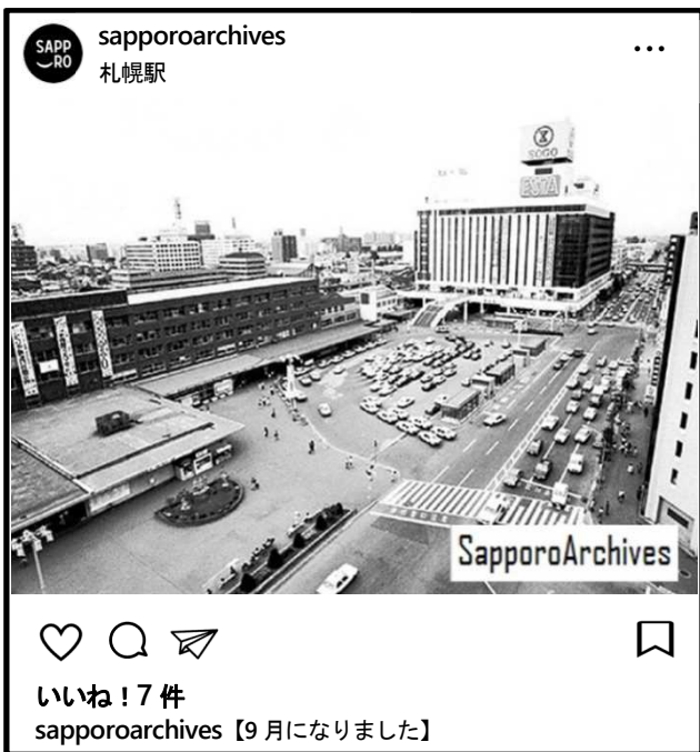
当館インスタグラム令和5年9月2日投稿より(札幌駅前商業施設の閉店に寄せて。写真は登録番号 AD36506)
