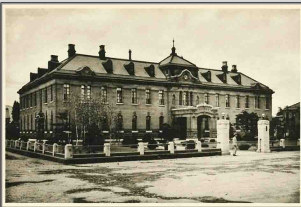
① 旧札幌控訴院（現・札幌市資料館）大正15年（1926）～現存
