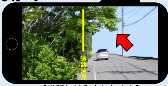
【道路にはみ出した庭木】
