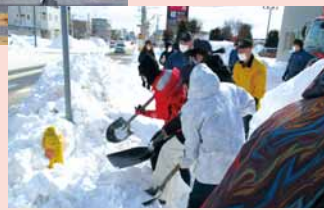
▲消火栓の除雪作業
