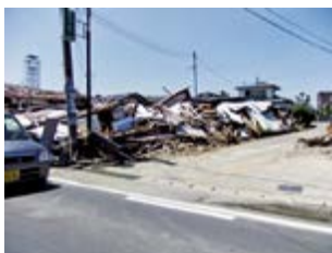
倒壊した家屋
