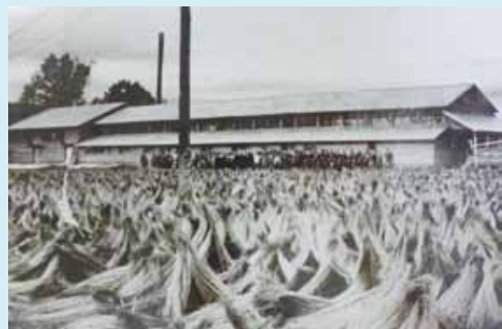
かつて麻生地区にあった製線工場
