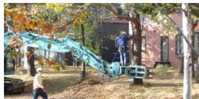
業者による伐採風景
