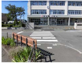
鴻城小学校前に設置された横断歩道
