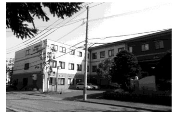
特別養護老人ホーム フローラルさつなえの 外観。
