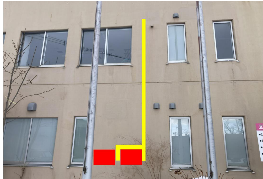
室外機設置予定箇所（赤色は室外機、黄色は配管）
