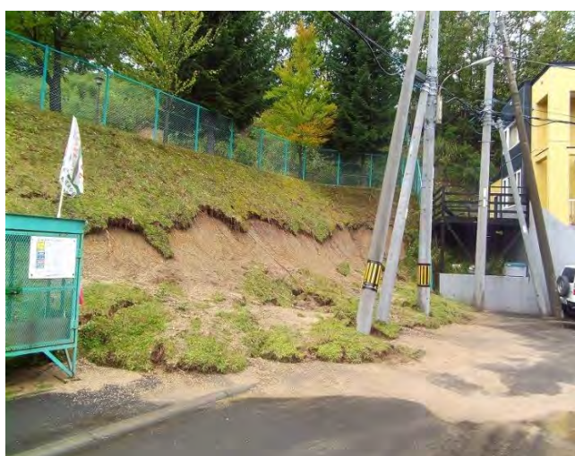
南区真駒内（緑地法面崩落）
