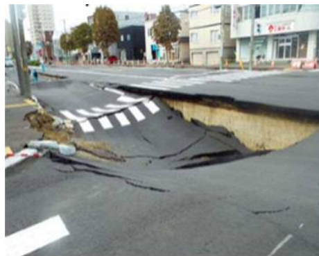
北海道胆振東部地震による道路陥没 ＜資料＞札幌市
