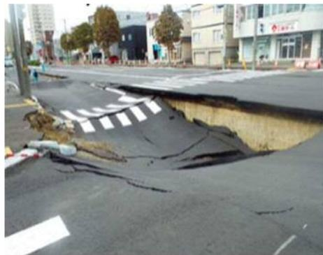
北海道胆振東部地震による道路陥没
