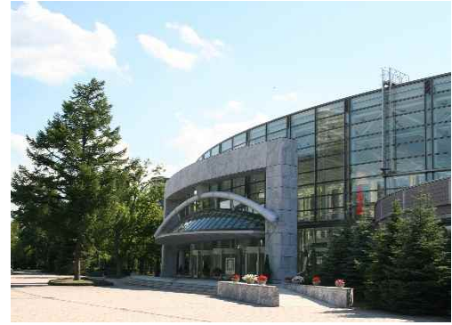
札幌コンサートホール(Kitara) ＜資料＞札幌市
