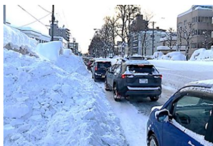
写真:堆雪により道幅が減少した道路
