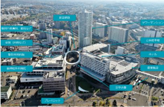
写真:整備後の新さっぽろ駅周辺(I街区)
