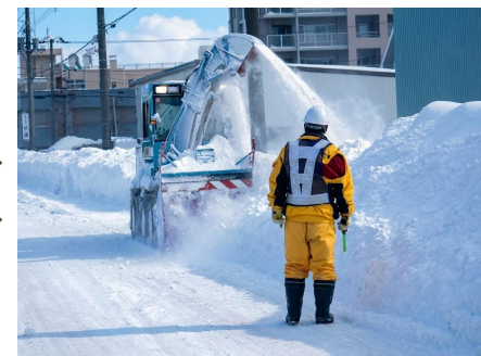
拡幅除雪の作業状況
