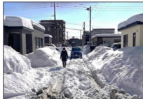
ザクザク路面が発生した「生活道路」
