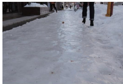
つるつる路面の歩道
