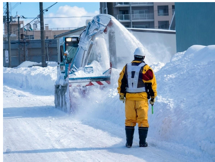
拡幅除雪の作業状況
