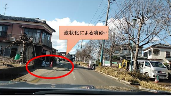
▲2024年1月4日, 新潟市西区善久, 能登半島地震による液状化(噴砂)箇所
