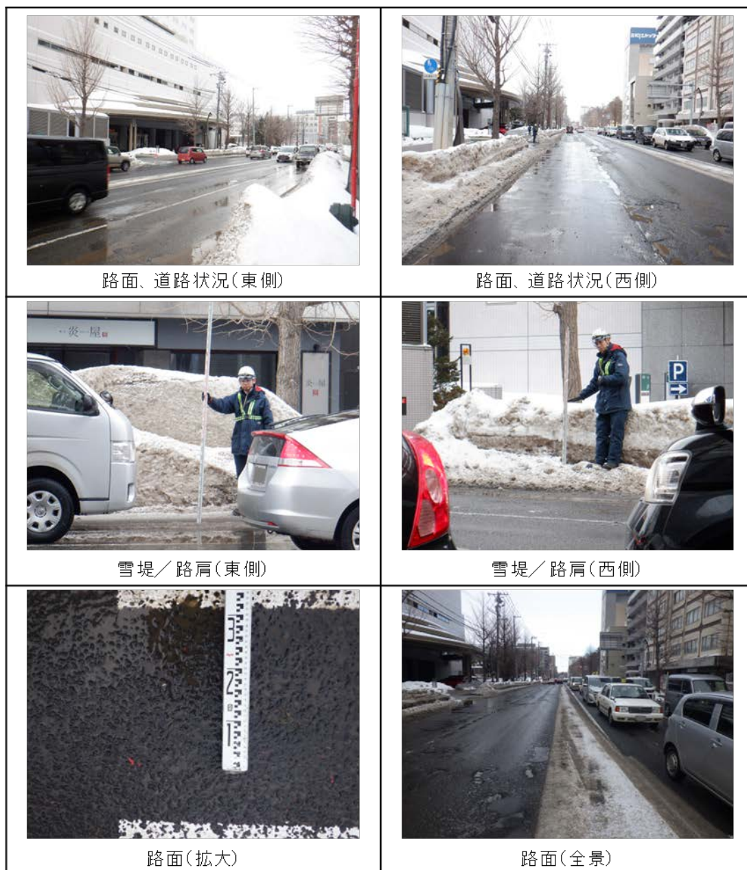
参考写真 1.3 側線 3 の調査状況 (第 1 回 2024 年 2 月 7 日)
