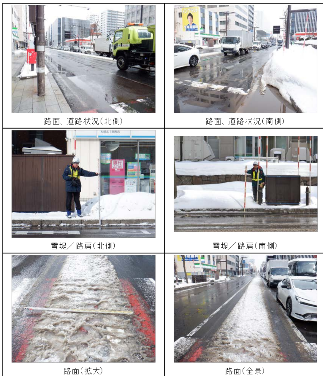
参考写真 1.6 側線 2 の調査状況 (第 2 回 2024 年 2 月 16 日)
