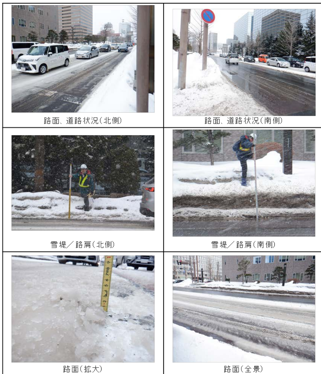
参考写真 1.8 側線 4 の調査状況 (第 2 回 2024 年 2 月 16 日)
