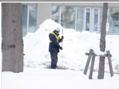
雪堤／路肩(東側)
