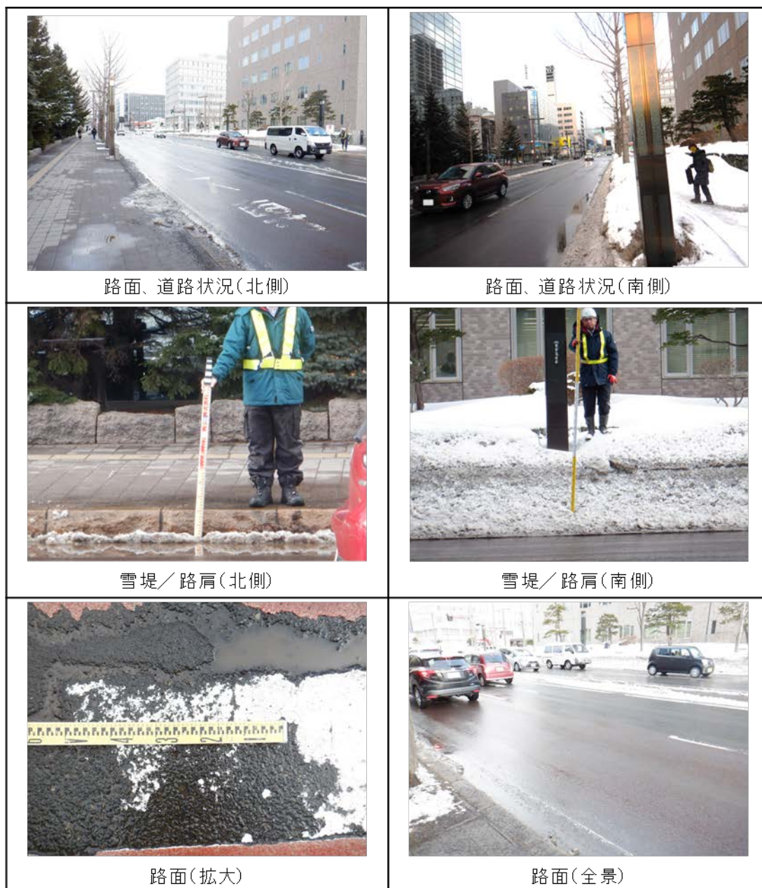
参考写真 1.20 側線 4 の調査状況 (第 5 回 2024 年 3 月 19 日)
