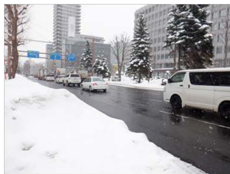
路面、道路状況(西側)
