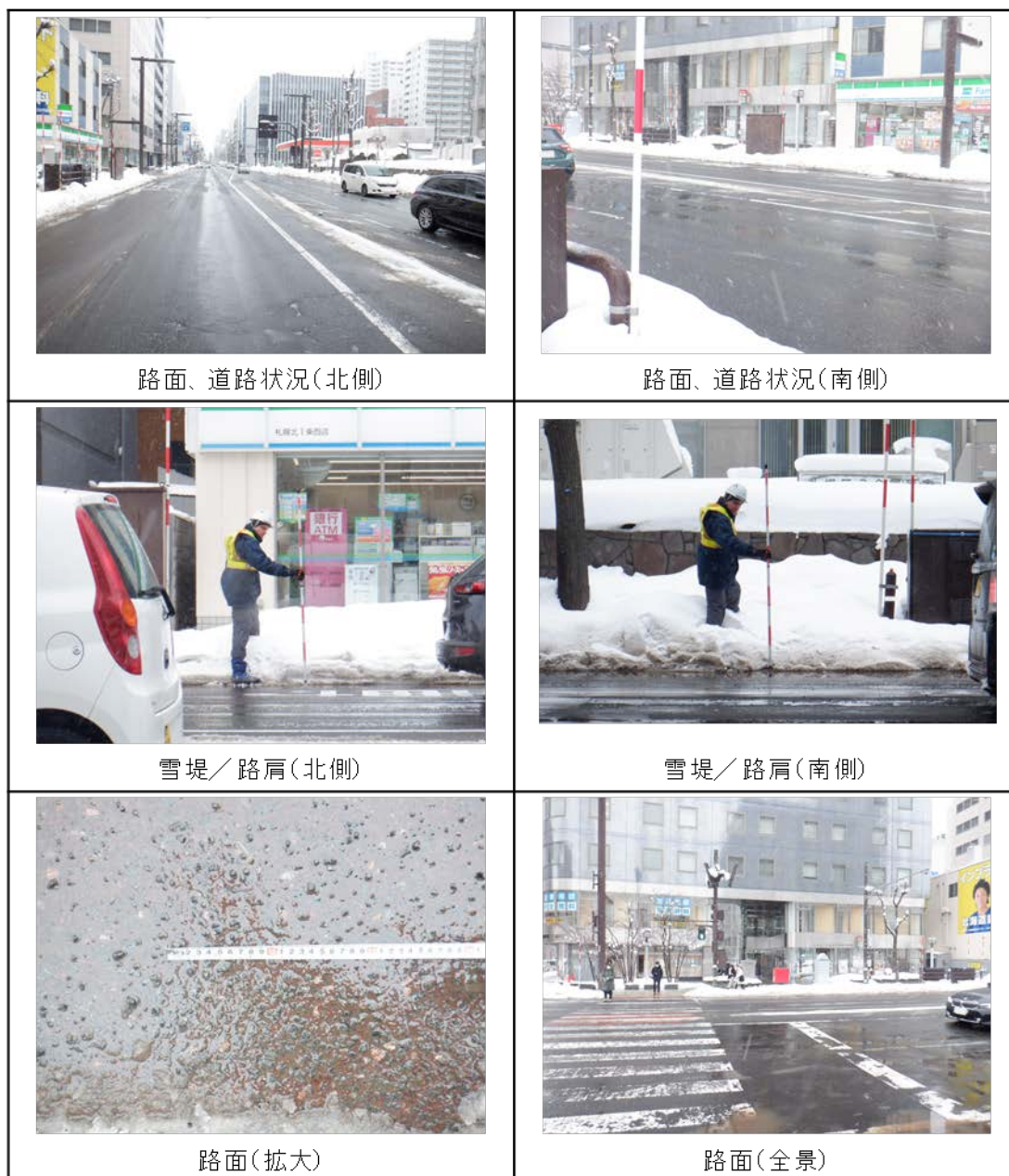
参考写真 1.10 側線 2 の調査状況 (第 3 回 2024 年 2 月 26 日)
