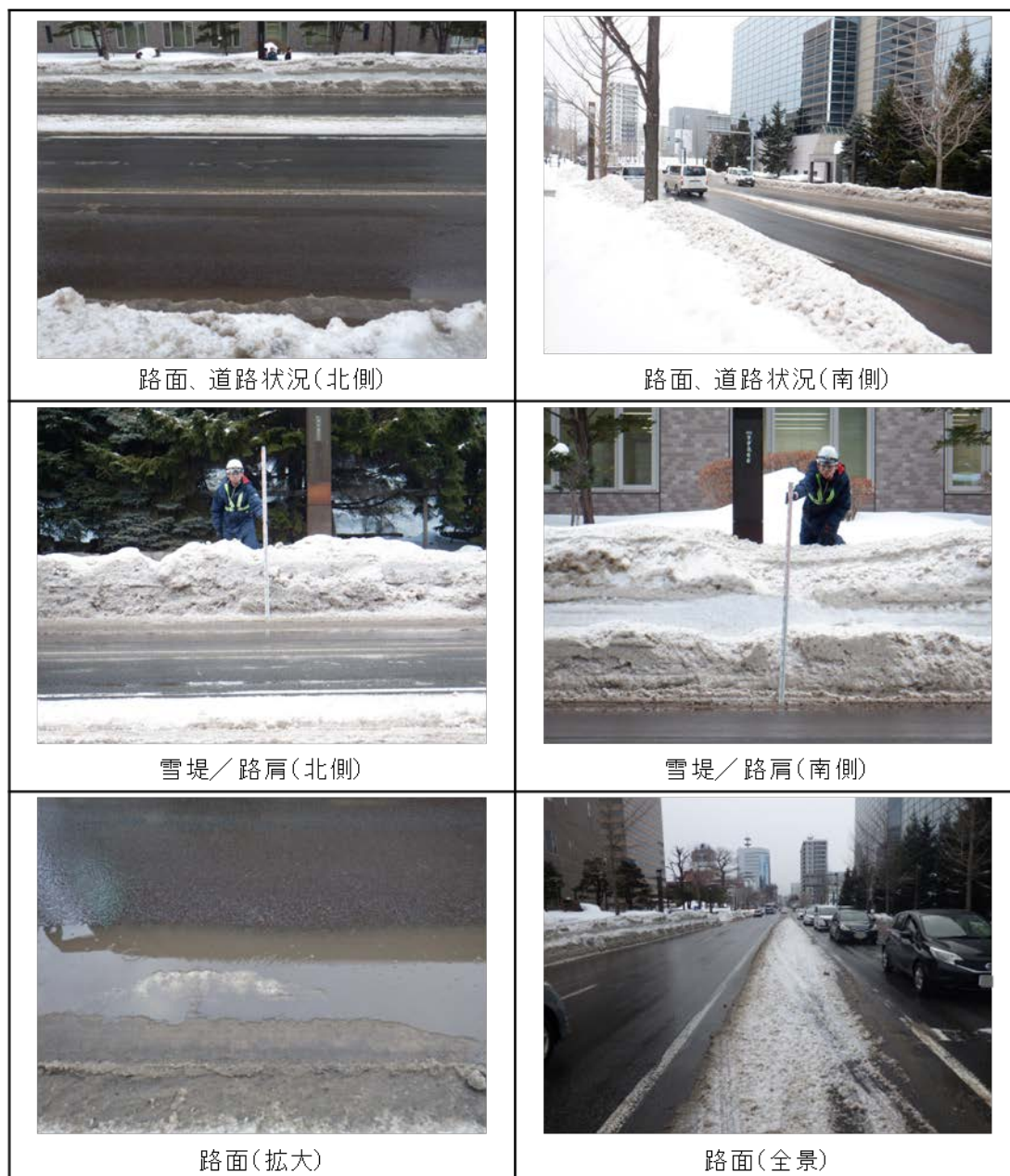
参考写真 1.4 側線4の調査状況 (第1回 2024年2月7日)
