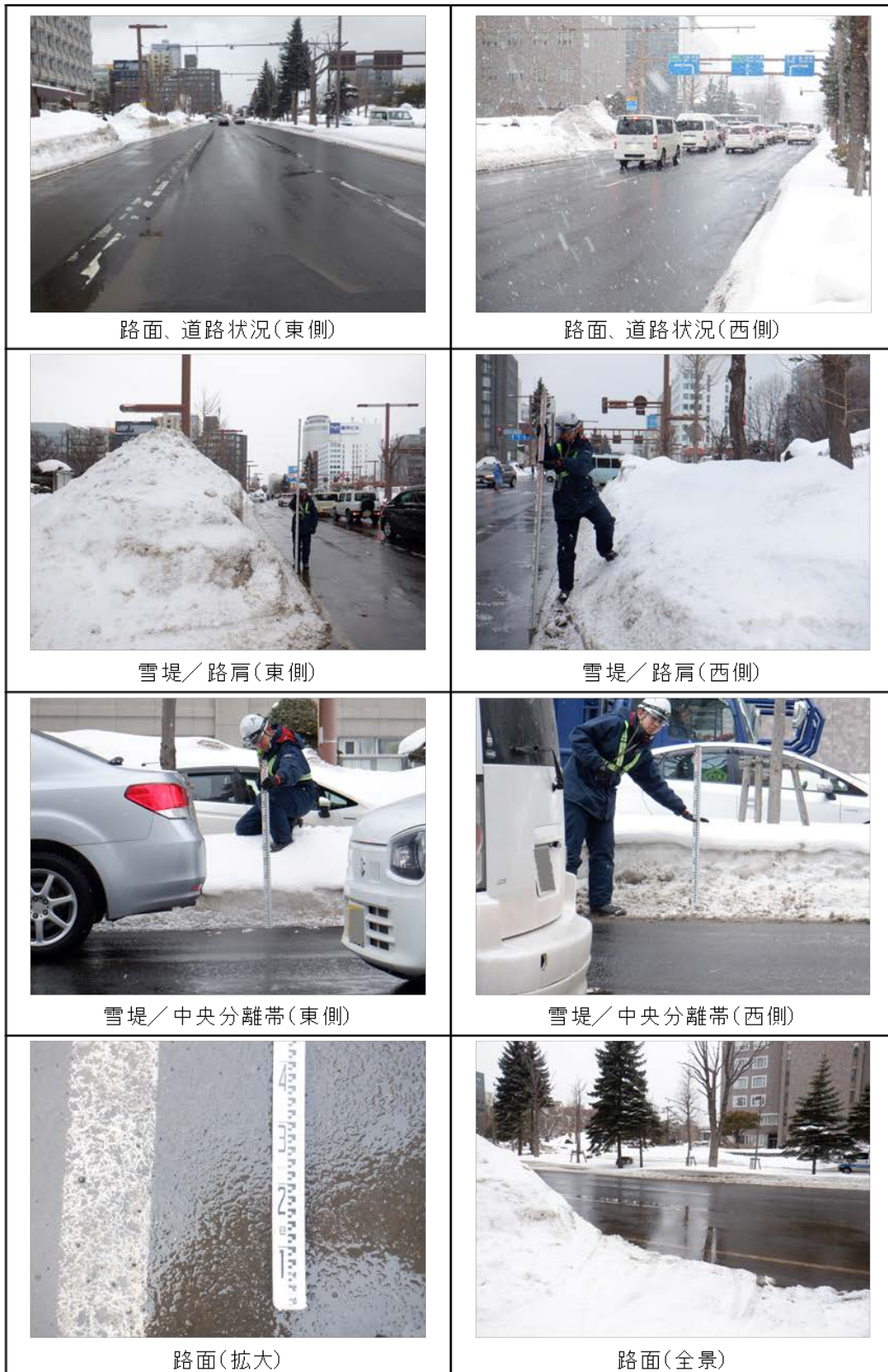
参考写真 1.1 側線1の調査状況 (第1回 2024年2月7日)
