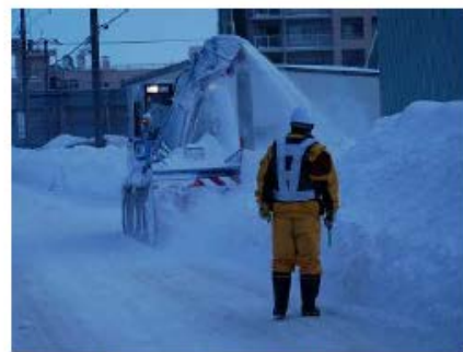
拡幅除雪の作業状況
