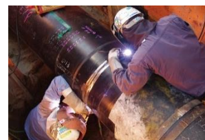
耐震性の高い溶接鋼管 可とう性に優れたPE管 3
