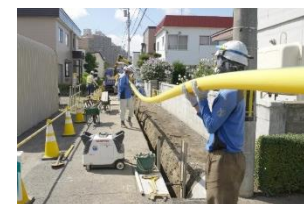
耐震性の高い溶接鋼管 可とう性に優れたPE管 3
