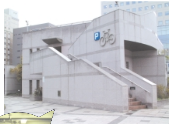
■ 札幌駅 北口駐輪場
