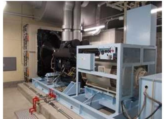
停電時にチ・カ・ホに電力を供給する非常用発電機
