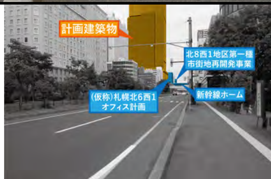
建設後写真8.1.12-8 地点8：札幌教会からの景観の変化(夏季)
