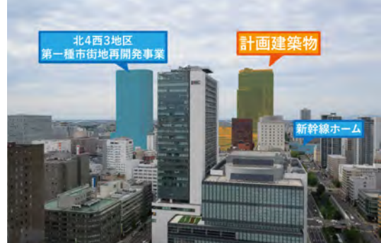
建設後写真8.1.12-11 地点11：さっぽろテレビ塔展望台からの景観の変化(夏季)
