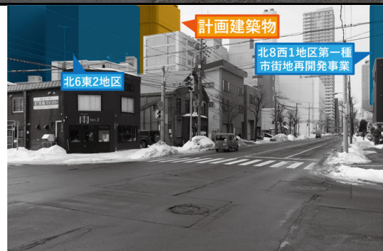
建設後写真8.1.12-7(3) 地点7：北8条東4丁目線交差点からの景観の変化(冬季)
