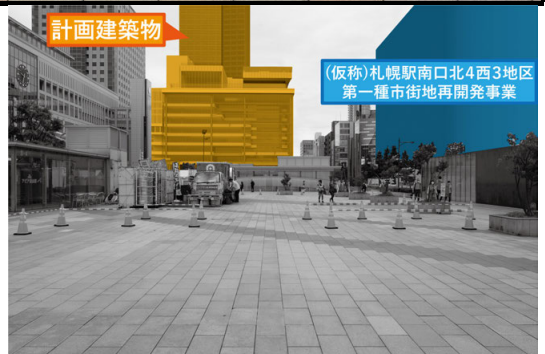
建設後写真8.1.12-1(1) 地点1：南口駅前広場からの景観の変化(夏季)
