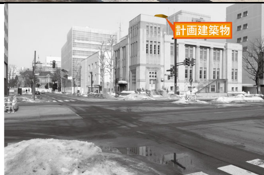
建設後写真8.1.12-9(3) 地点9：交差点(北1西6)からの景観の変化(冬季)
