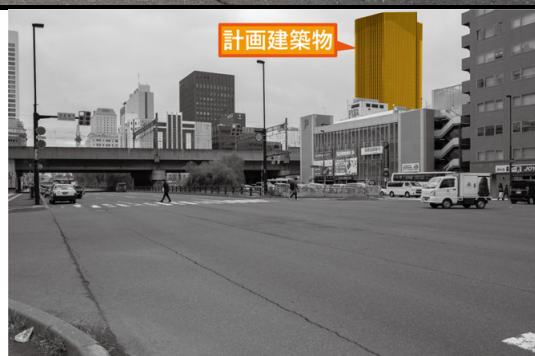
建設後写真8.1.12-7(2) 地点7：交差点(北7西1)からの景観の変化(落葉季)
