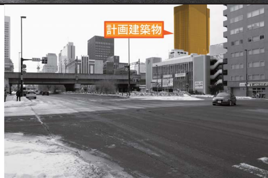
建設後写真8.1.12-7(3) 地点7：交差点(北7西1)からの景観の変化(冬季)
