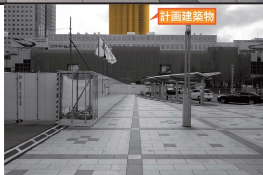
建設後写真8.1.12-6(2) 地点 6：札幌駅北口交番からの景観の変化(落葉季)
