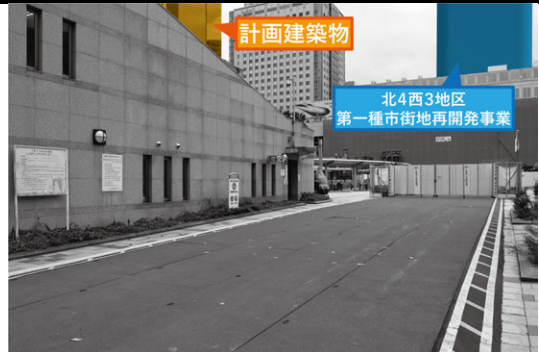
建設後写真8.1.12-2(2) 地点2：札幌駅北口交番からの景観の変化(落葉季)
