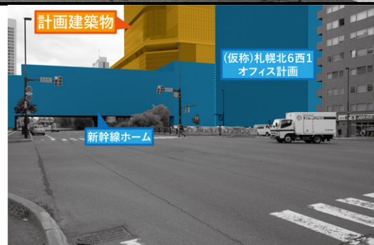
建設後写真8.1.12-3(1) 地点3：北7条創成川通交差点からの景観の変化(夏季)
