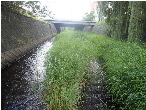
開放水域(創成川)の様子(北側) (令和2年10月14日撮影)
