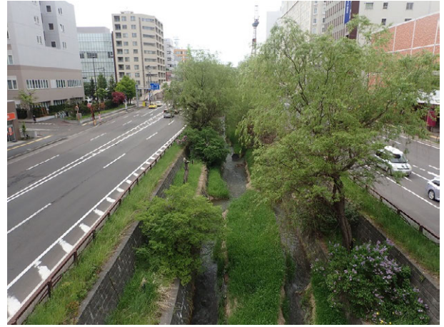
残存・植栽樹群地の様子(南側) (令和3年5月21日撮影)
