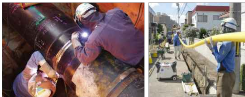
溶接鋼管、ポリエチレン管への更新工事の様子
