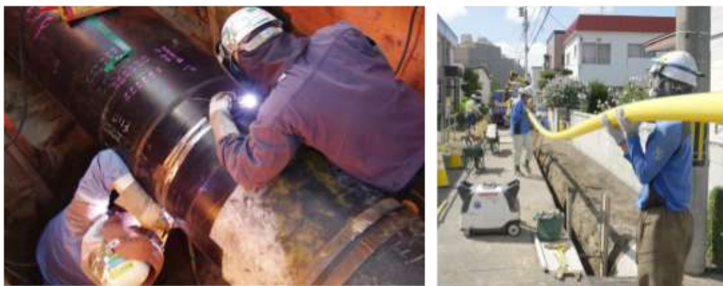
溶接鋼管、ポリエチレン管への更新工事の様子(北海道ガス㈱ 提供)
