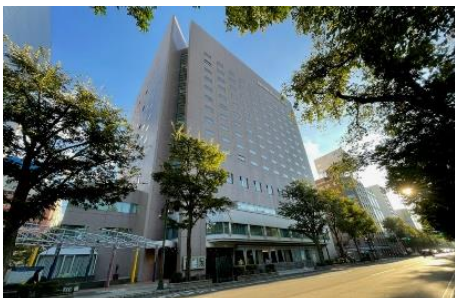
⑥大通公園沿道に立地するホテル
