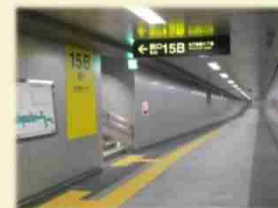
【参考イメージ】北8西1地下通路
