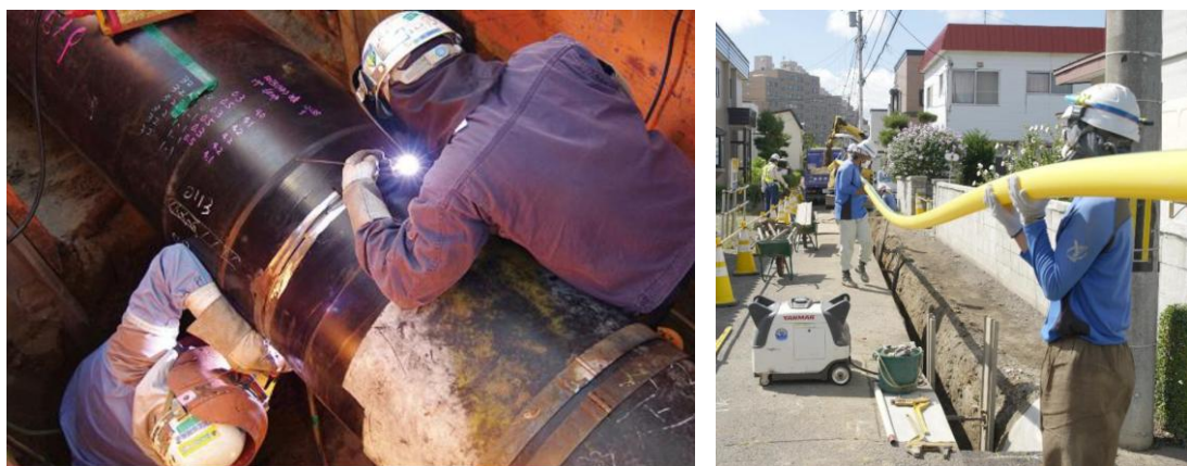
溶接鋼管、ポリエチレン管への更新工事の様子(北海道ガス(株)提供)
