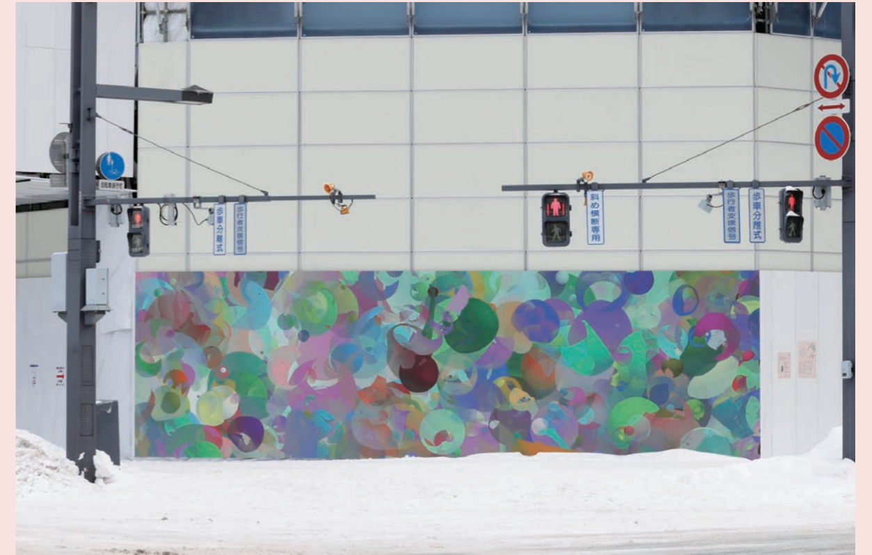
📍 ヒューリック札幌建替計画 仮囲い（札幌市中央区北3条西3丁目）
