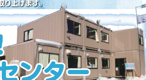
西区南地区除雪センター (宮丘公園内に仮設で設置されている)
