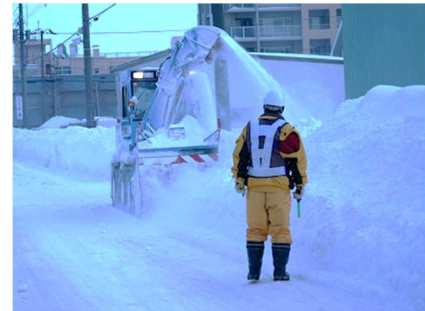
拡幅除雪の作業状況
