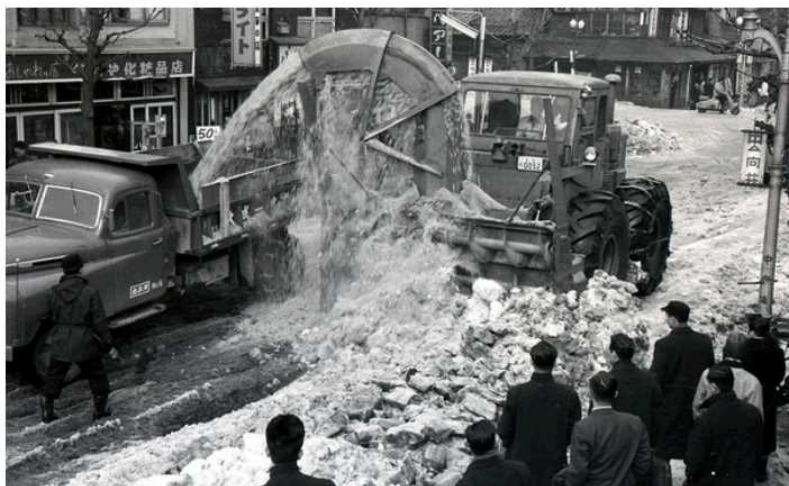
ロータリ除雪車による排雪作業
