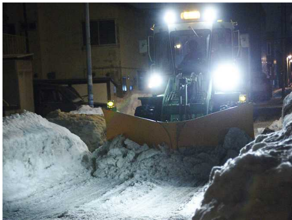
路面整正の作業状況
