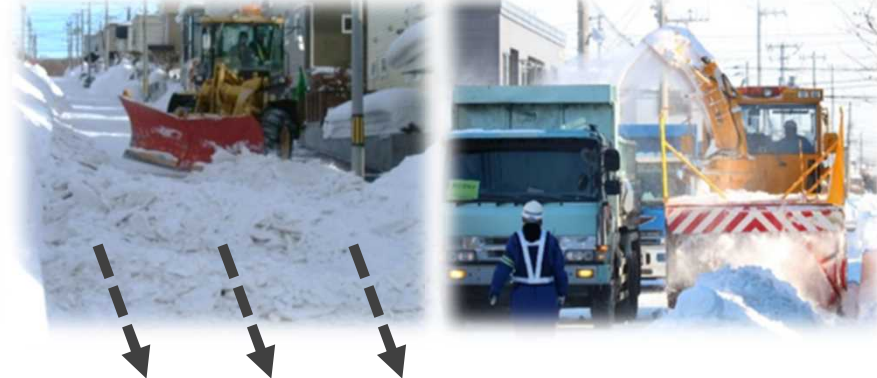
削り出し作業のイメージ 積込作業のイメージ
