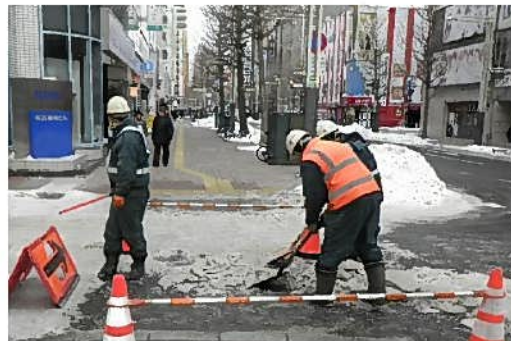
氷板除去作業
