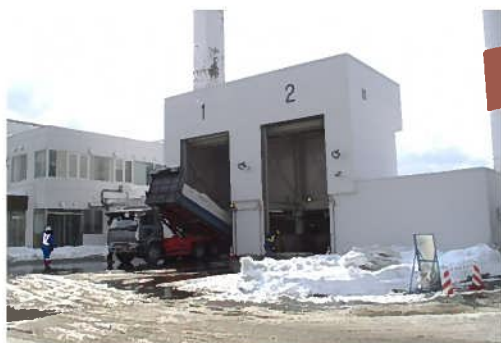
新川融雪槽（現状）
