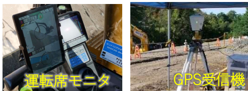
ICT土工の施工状況
