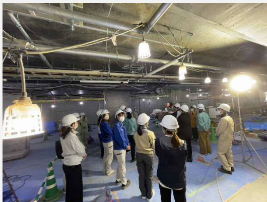
現場見学（西2丁目地下駐車場整備工事）
