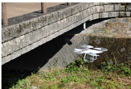
ドローンを使った橋梁の点検
