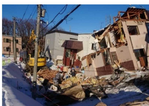
平成30年北海道胆振東部地震 での被災家屋の除去
