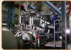
下水道処理設備の点検
