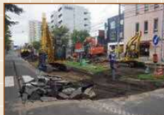
地震による被害の応急復旧 2018年(平成30年)9月
