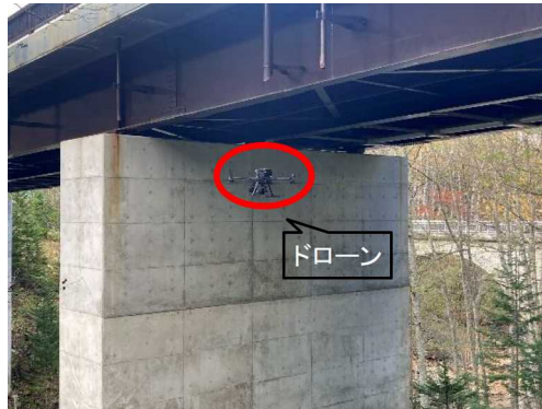
ドローンを使った橋梁の点検
