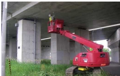
橋梁点検の実施
