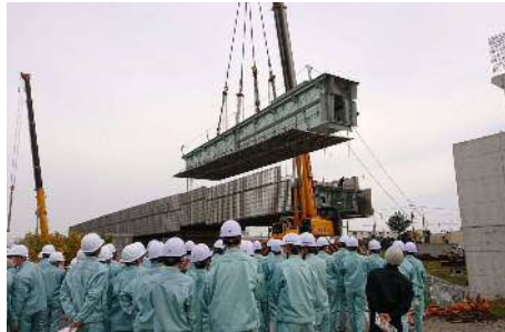
札幌工業高校現場見学（橋梁工事）
